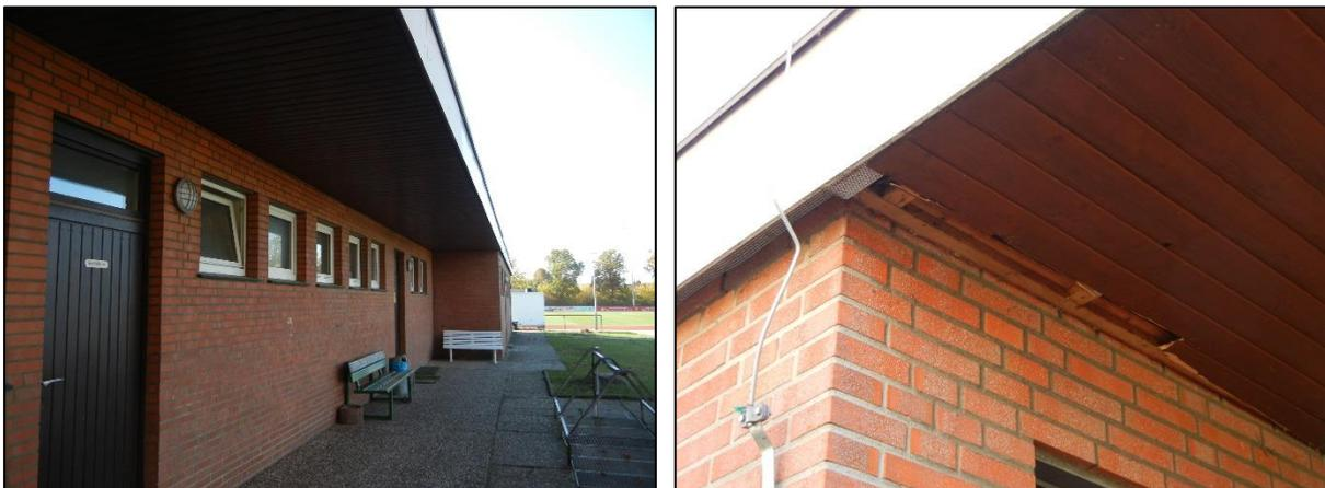
**Abbildung 10: Umkleidegebäude mit teilweise beschädigter Holzdeckenverkleidung**
